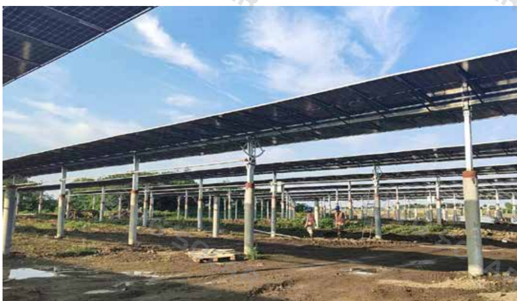
江苏丹阳180MW跟踪项目 180 MW - Jiangsu,China
